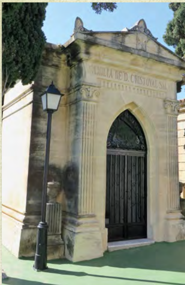
Panteón de la familia Salvá en Altea. El cementerio se construyó en 1.864.
