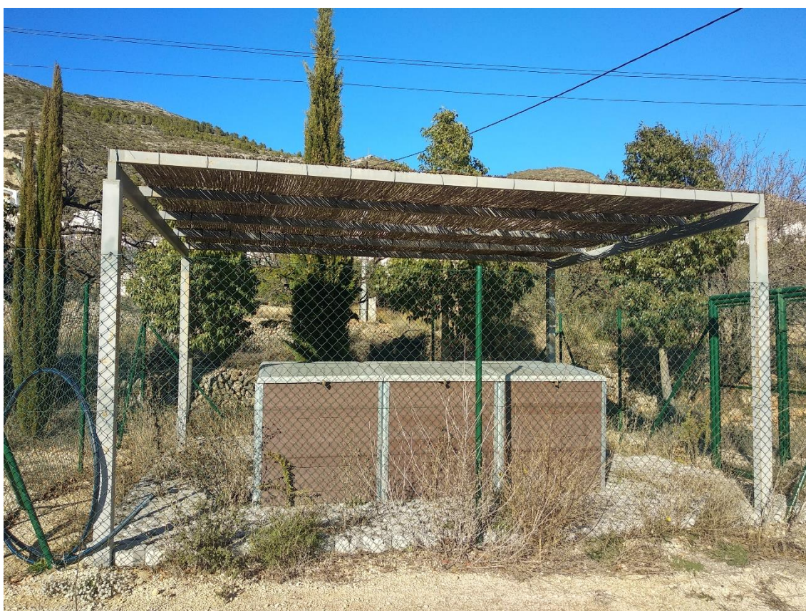
Imagen 19. Ejemplo de Instalación de compostaje comunitario en Xaló. Inteligencia Climática (2020)
