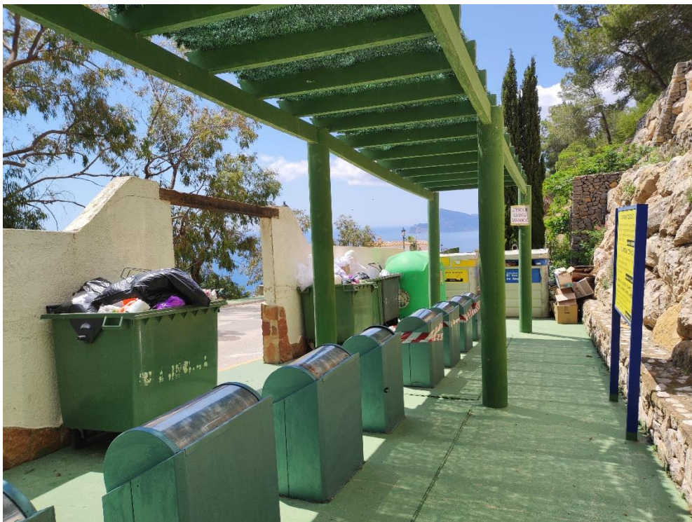
Fotografía 9. Área de aportación en la Urb. Galeras Altas. Inteligencia Climática (3-05-2022)
