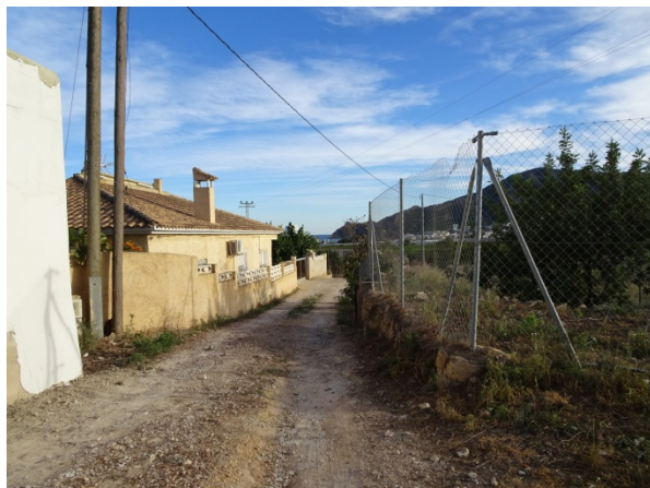
Camino de acceso a la incidencia nº2.
