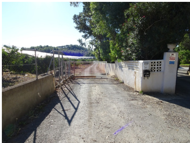
Vista general de la puerta que impide el paso
