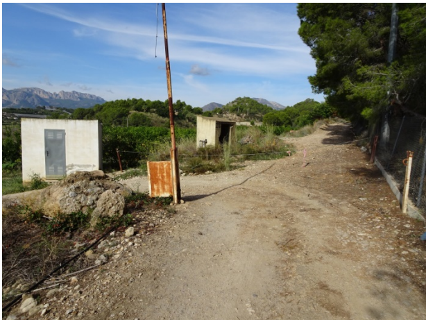
Vista general del lugar en el que está cortado el camino
